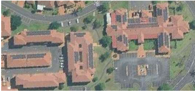
Installasie van sonpanele
